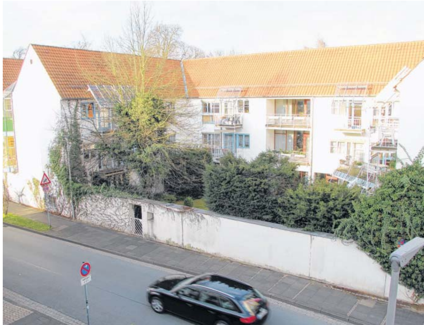
Objekt mit Zukunft: Das Kreisaltenheim an der Echternstraße soll umgebaut und dann an eine Betriebsgesellschaft vermietet werden.
